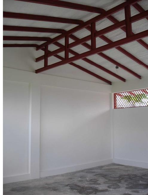
Estructura de techo, correas IPN y viga vierendel
