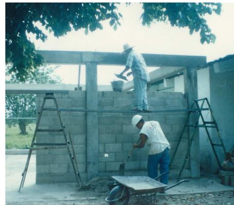
Construcción de fundaciones, vigas de riostra, columnas, vigas de carga y paredes.
